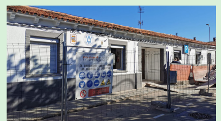
Treballs de rehabilitació del local
