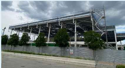
Estat actual de les obres
