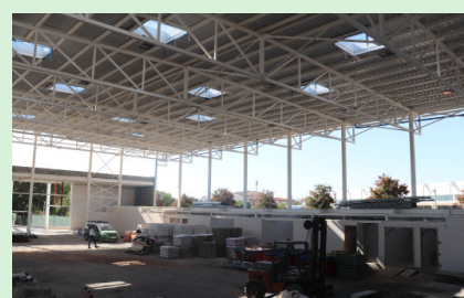
Estat actual de les obres del pavelló
