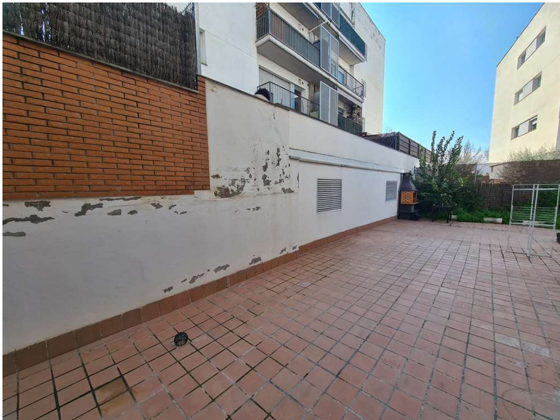
IMATGE 6. Vista general del mur de contenció i paret de separació entre finques, des del pis Baixos 3a de la finca C/ Pompeu Fabra, 12-14. Data 28-03-2025.
