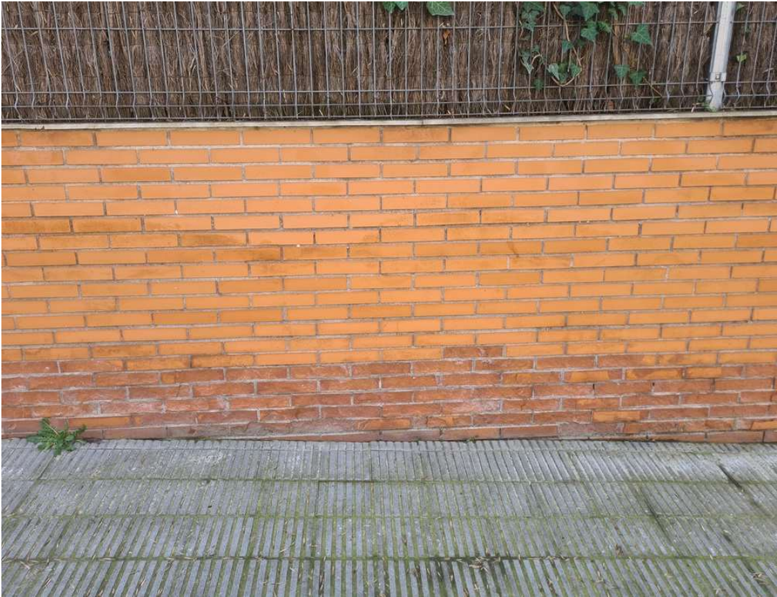
IMATGE 12. Detall de la tanca d'obra vista amb humitats a la part baixa i la degradació de les peces ceràmiques. Data 28-03-2025.
