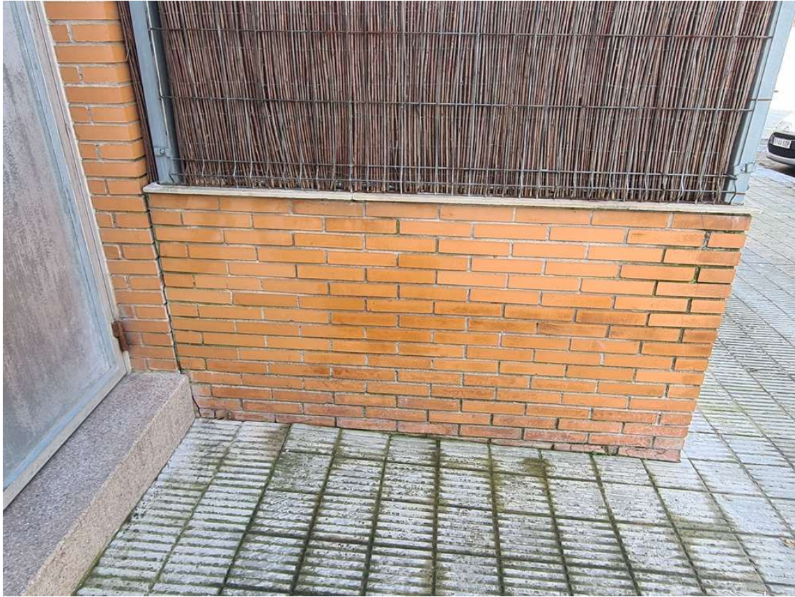
IMATGE 8. Tanca perimetral d'obra vista, zona de l'entrada al bloc del C/ Pompeu Fabra, 16. Data 28-03-2025.
